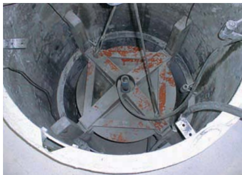
Ofenzustellung mit NKH
